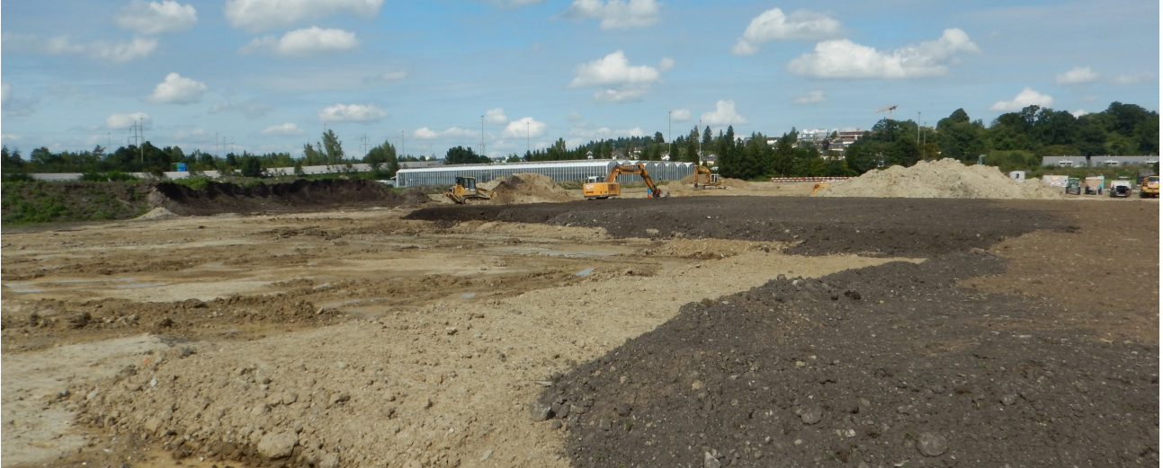
Bodenauftrag Kompensationsfläche (Quelle: FRIEDLIPARTNER AG)
