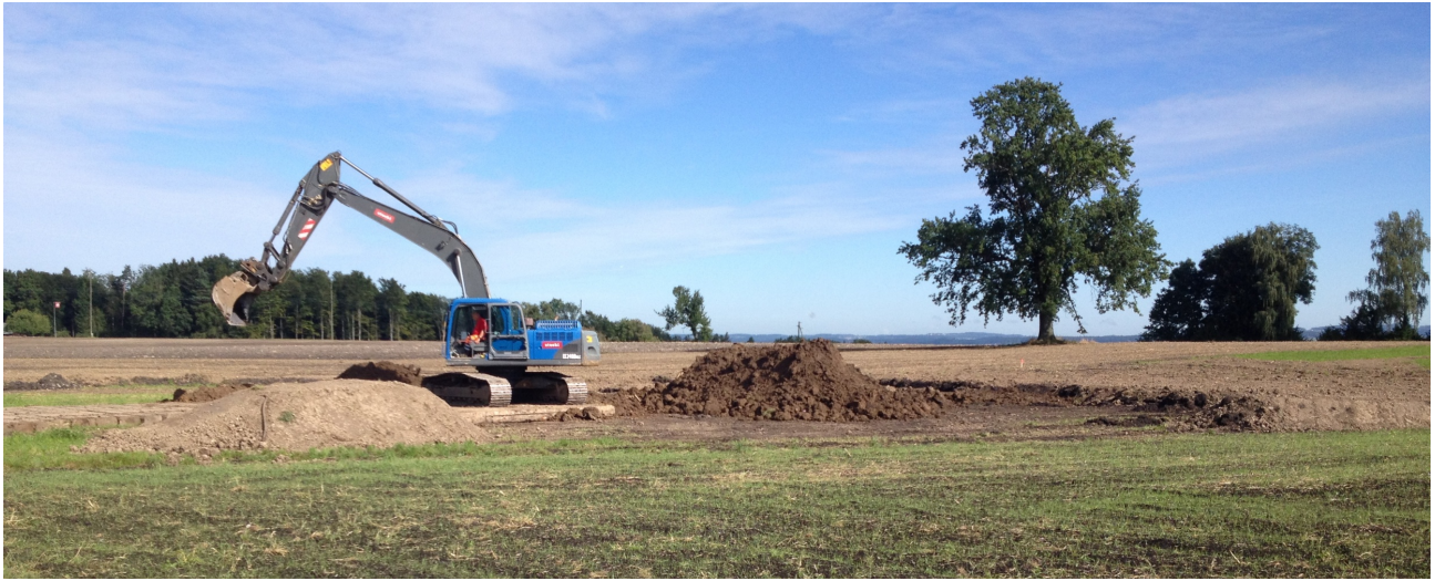
Bodenauftrag Etappe 1 (Bild: FRIEDLIPARTNER AG)
