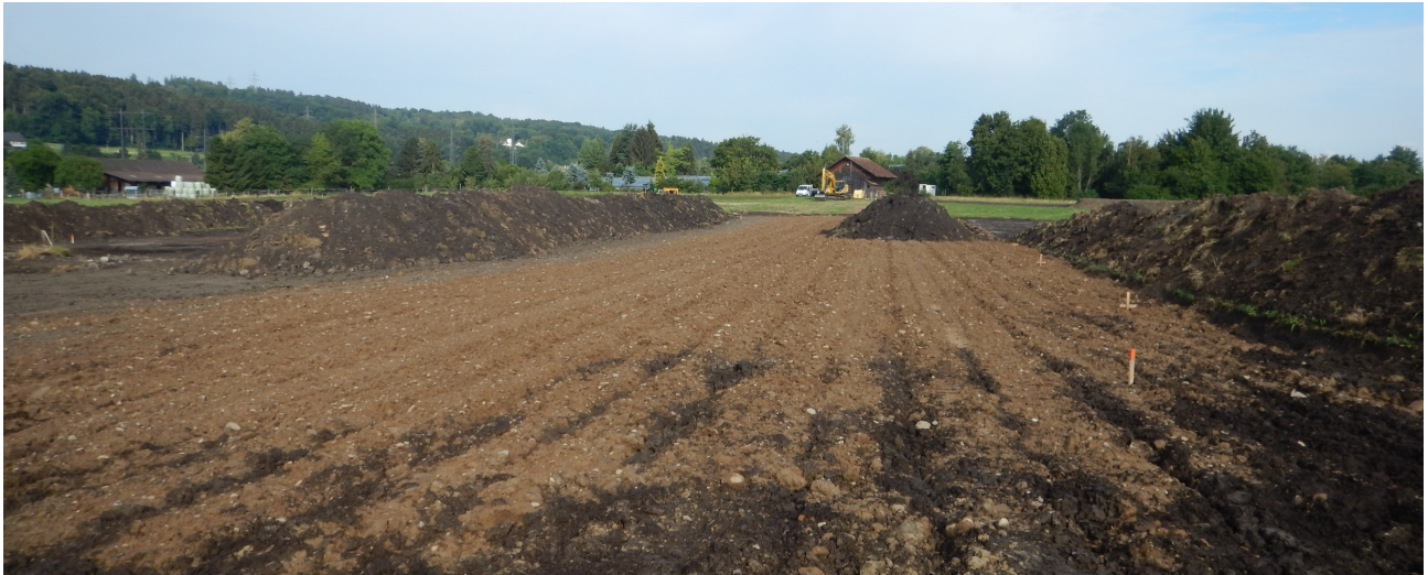
Bodenauftrag Etappe 1 (Bild: FRIEDLIPARTNER AG)
